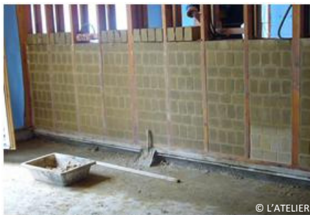
MONTAGE DES MURS EN BTC EN REMPLISSAGE D'OSSATURE
