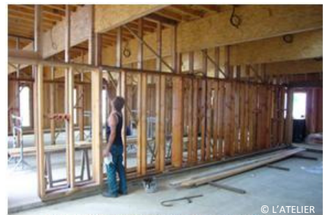
PRÉPARATION DES OSSATURES BOIS AVEC UNE HUILE D'IMPRÉGNATION
