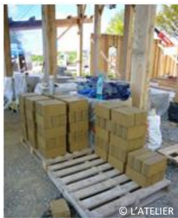
MISE EN PALETTE SOUS BÂCHE POUR CURÉ HUMIDE
